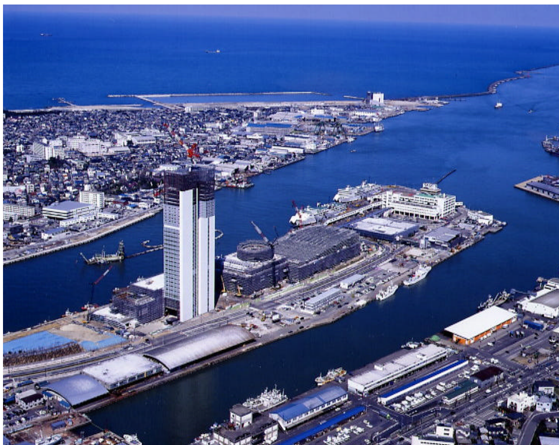
整備の進む万代島 (平成14年3月)
