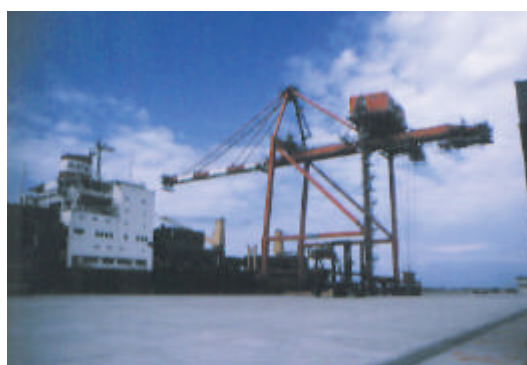
新潟港 (東港区西ふ頭) (外貿専用ターミナル)
