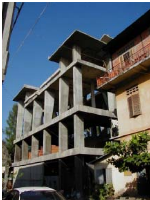
写真 - カンボジア国首都プノンペンに建設中の「ひろしまハウス」
